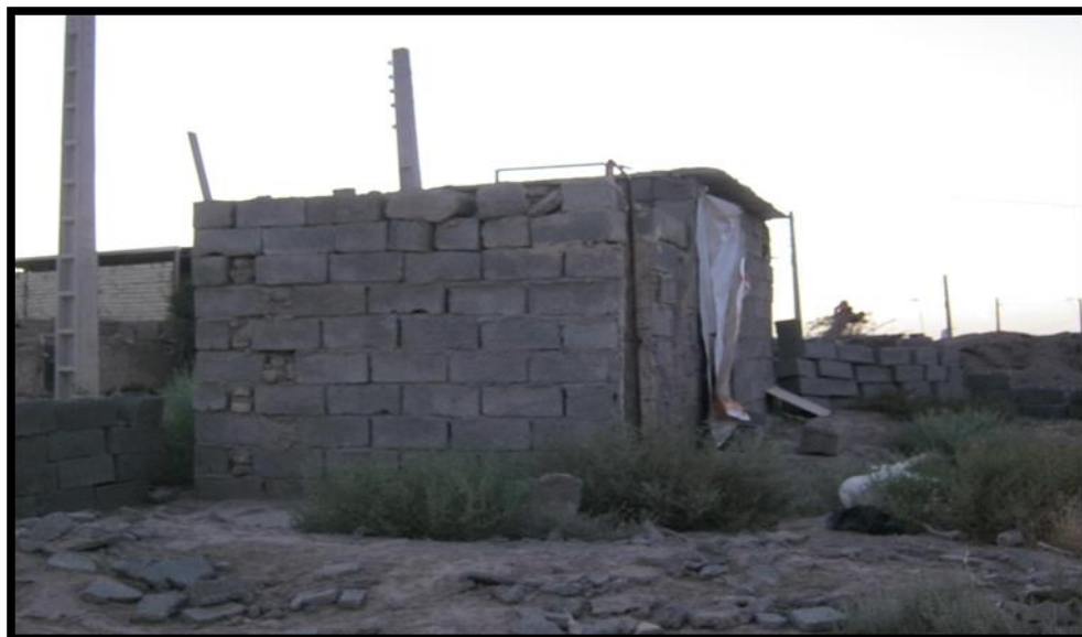
شکل ۴-۴: استفاده از مصالح نامرغوب (سلیمانی، ۱۳۹۵)
