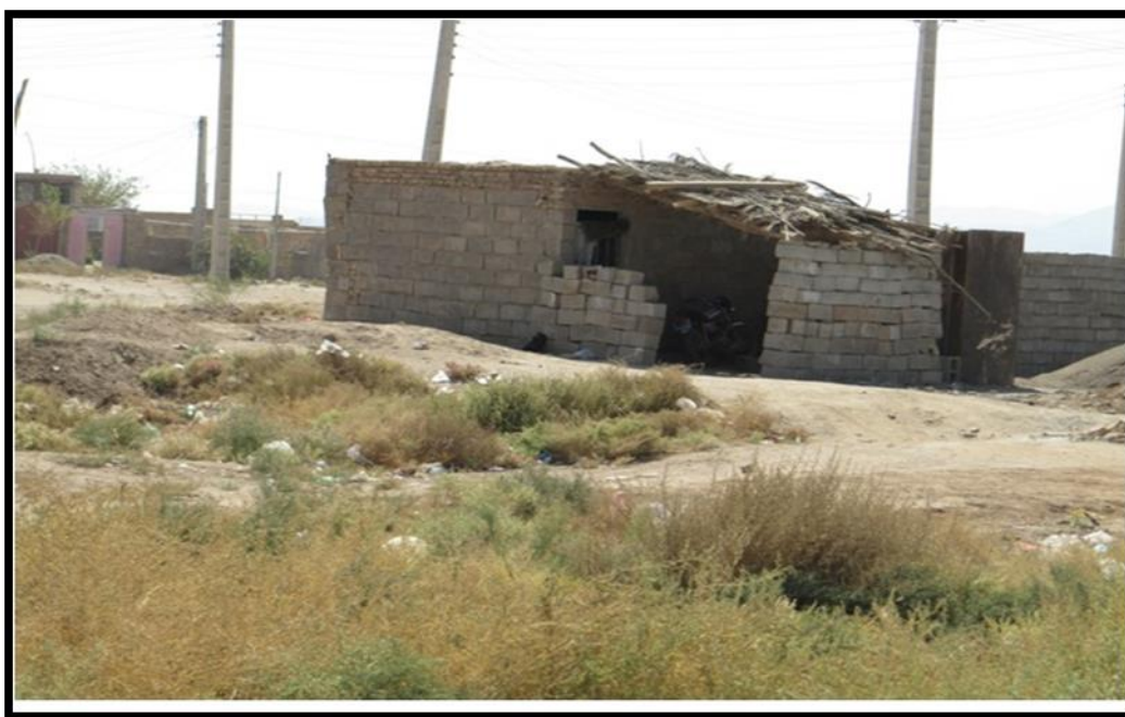
شکل (۳-۴): استفاده از مصالح نامرغوب ( سلیمانی، سعید ۱۳۹۵)
