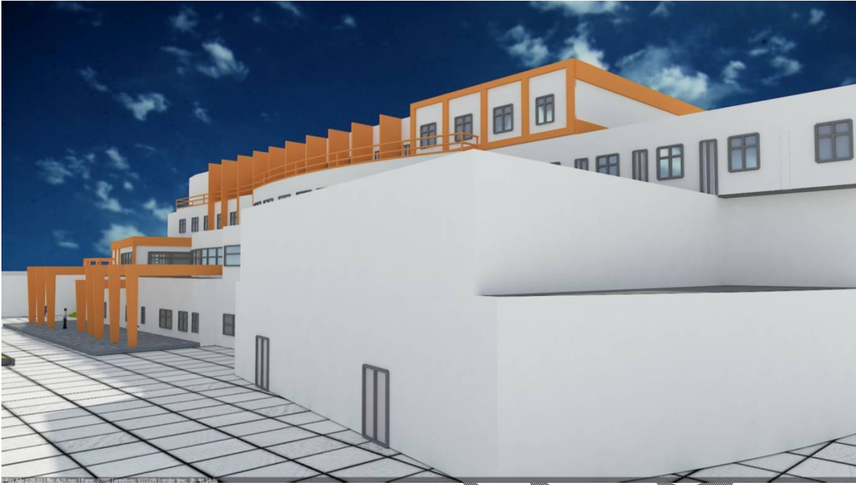
شکل 5-11: نمای جنوبی مجموعه
