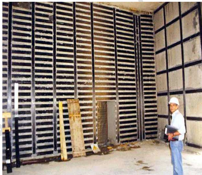
شکل ۲-۱۱ تقویت دیوار برشی با FRP
