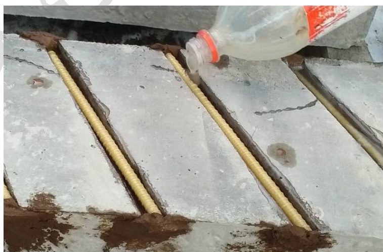
شکل ۳-۱۰ پر کردن شیار با چسب
