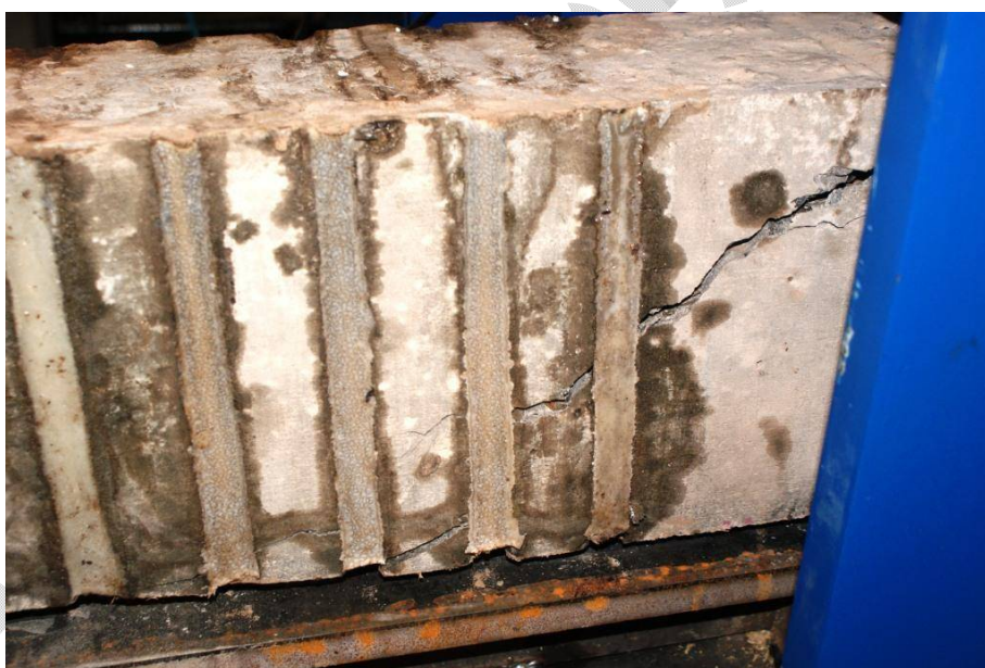
شکل ۳-۱۹ ترک خوردن و گسیختگی تیر NSMV7
