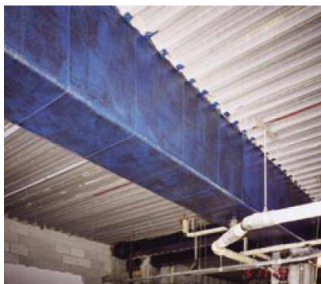
شکل ۲-۱۴ تقویت خمشی و برشی تیر با FRP
