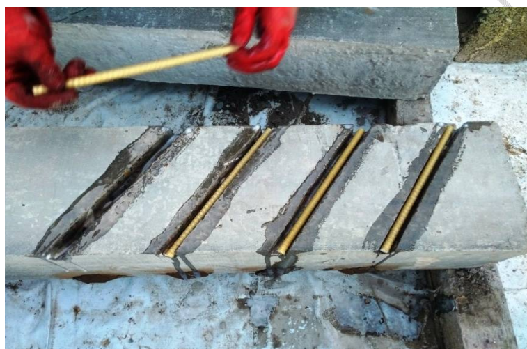
شکل ۳-۹ قرار دادن میلگرد GFRP در شیار
