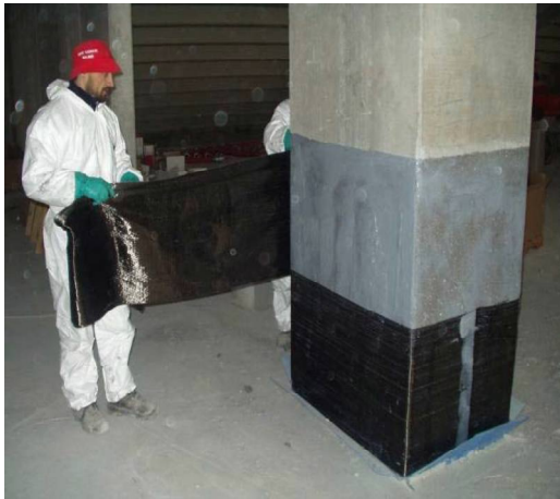
شکل ۲-۱۰ تقویت ستون با ورقه ی FRP
