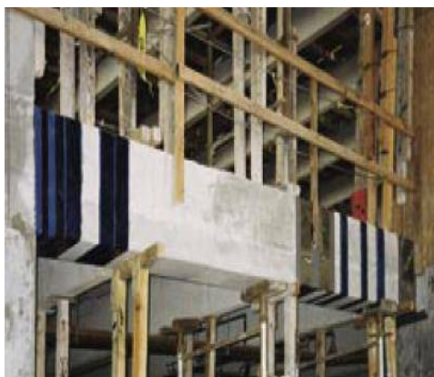
شکل ۲-۱۴ تقویت خمشی و برشی تیر با FRP
