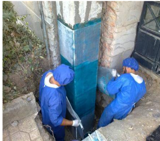
شکل ۲-۱۰ تقویت ستون با ورقه ی FRP
