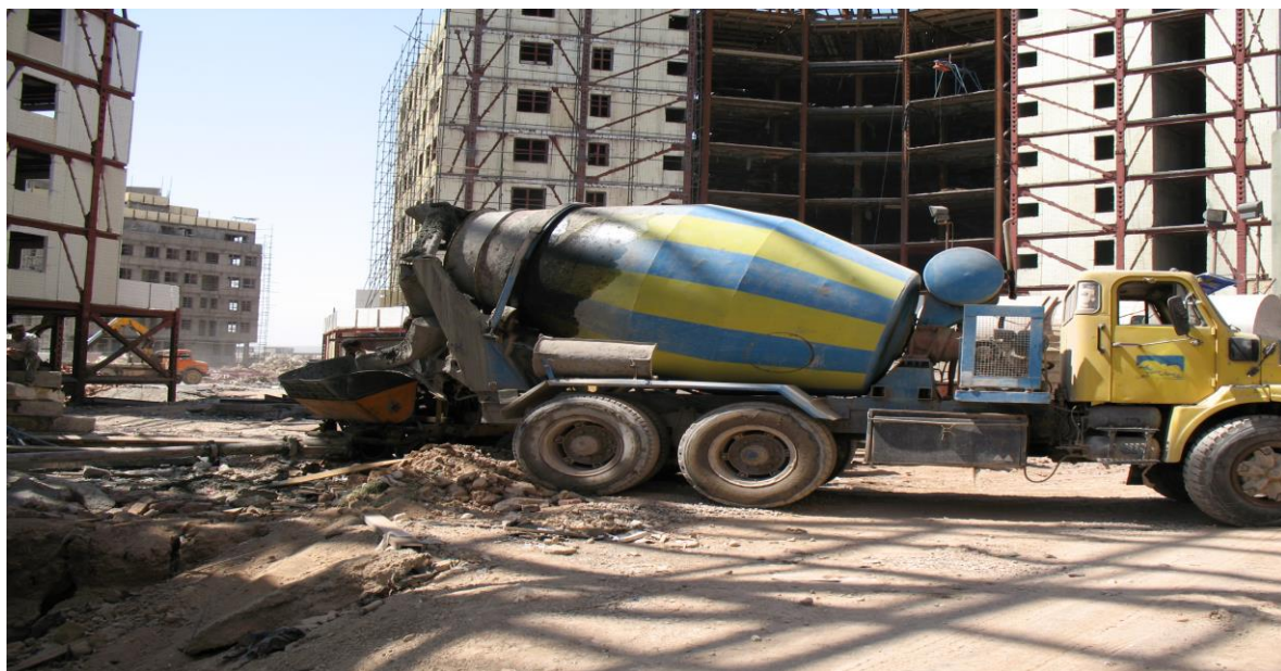
عکس شماره ۴: استفاده از تراک میکسر و پمپ به منظور حمل و انتقال
