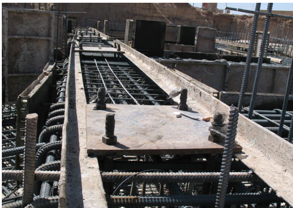
عکس شماره ۱۰: نصب کف ستون ها
