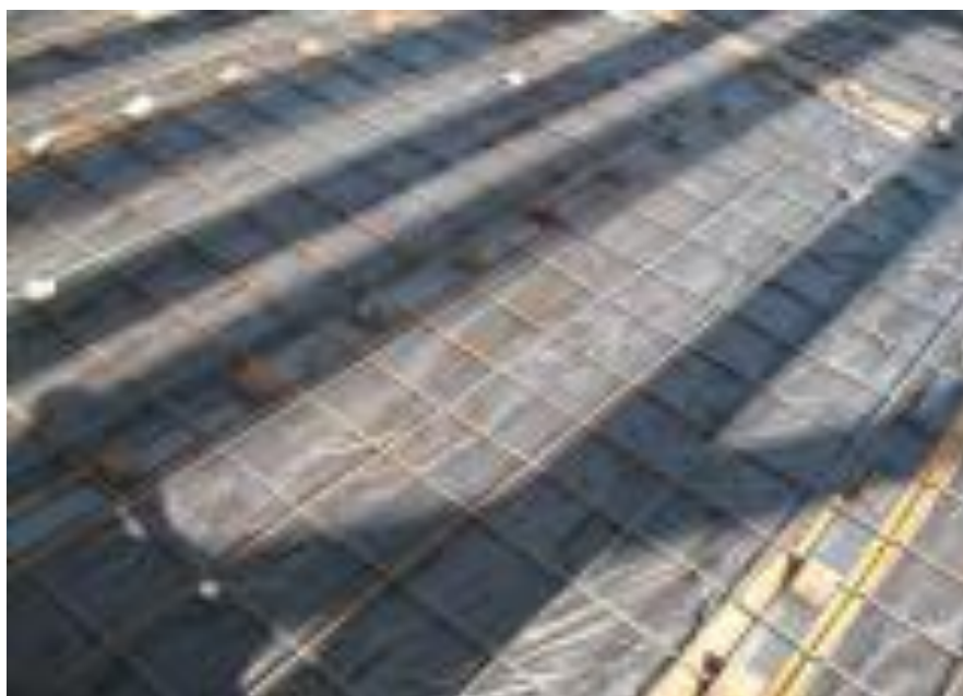
عکس شماره ۲۰: سقف کنترل شده و آماده بتن ریزی
