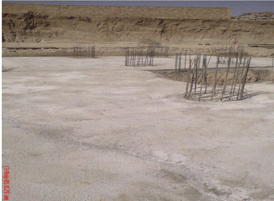
عکس شماره ۷: اجرای بتن مگر
