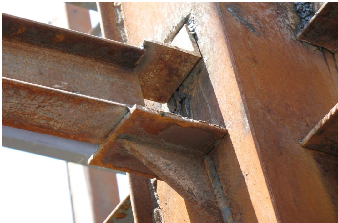
عکس شماره ۱۳ و ۱۴: عدم رعایت بادخور مناسب
