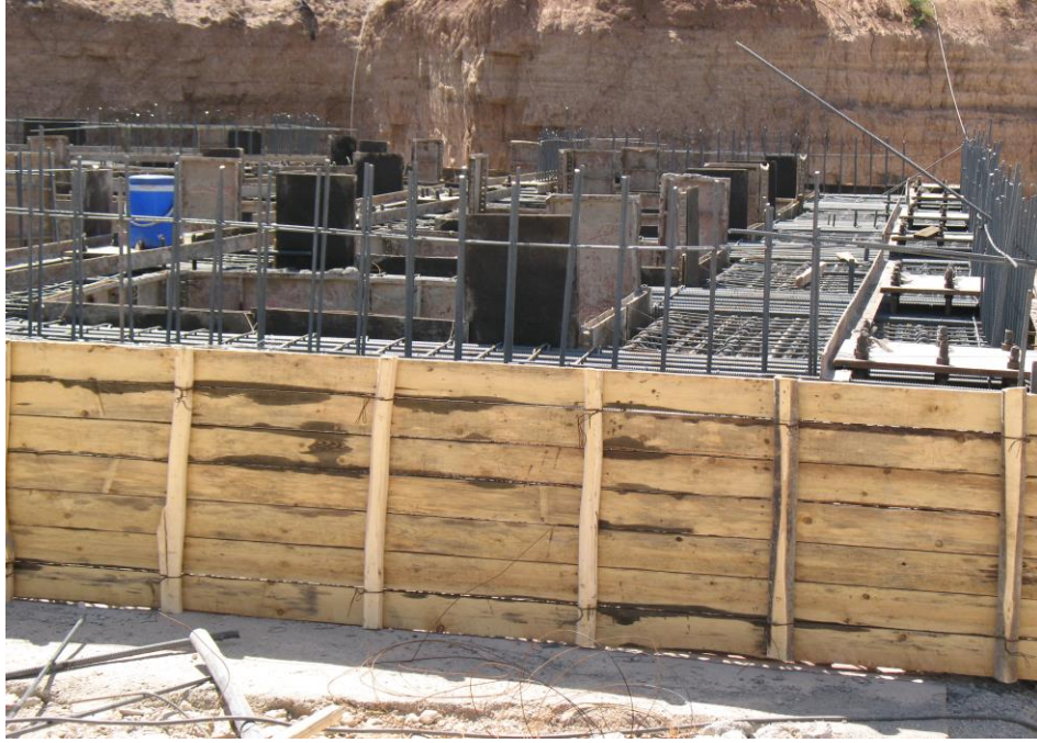
عکس شماره ۱۱: قالب بندی فنداسیون
