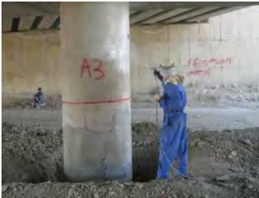
شکل ۶: اعمال لایه سطحی محافظ بر ستون تعمیر
