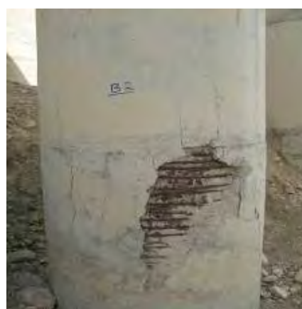
شکل ۴: نمونه ای از خرابی نوع C
