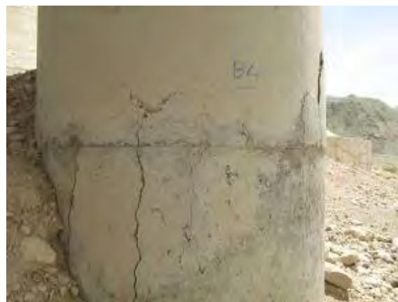
شکل ۳: نمونه ای از خرابی نوع B
